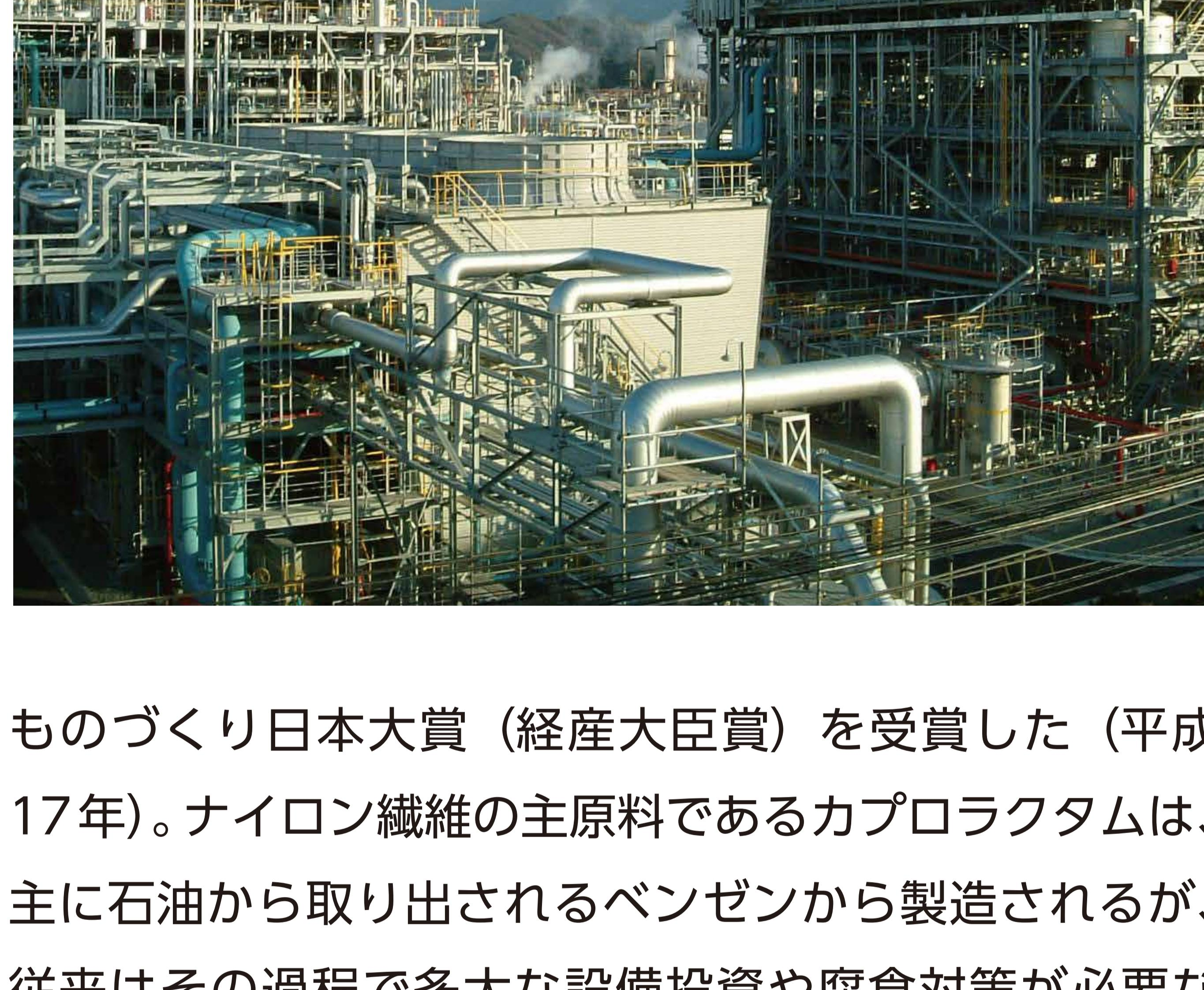
ものづくり日本大賞（経産大臣賞）を受賞した（平成17年）。ナイロン繊維の主原料であるカプロラクタムは、主に石油から取り出されるベンゼンから製造されるが、従来はその過程で多大な設備投資や腐食対策が必要な硫酸アンモニウム（硫安）が副生されていた。そのため、住友化学ではこの硫安が全く複製しないプロセスを世界で初めて開発・工業化し、設備費、補修費共に大幅に削減させた。
